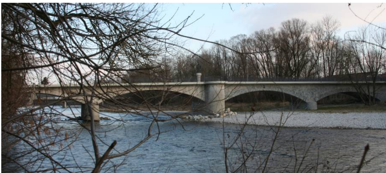
Die alte Isarbrücke aus dem 19. Jahrhundert spielte für pax christi eine wichtige Rolle als Ausgangspunkt von Friedensdemonstrationen in den 1980er Jahren.
